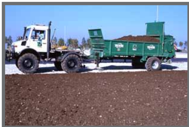
Bild 7: Rezeptur für vegetationsfähige Tragschicht: 35 Gew.-% schwach bindigen Oberboden, 15 Gew.-% Splitt-Schotter 2-16 mm, 50 Gew.-% Schotter oder Kies 16-63 mm.
