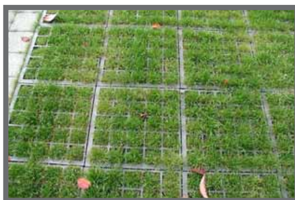
Kammerbegrünung - Gittersteine, Wabenelemente (Kunststoffgitter, Betongitter), Grünanteil 30 bis 90 %.
