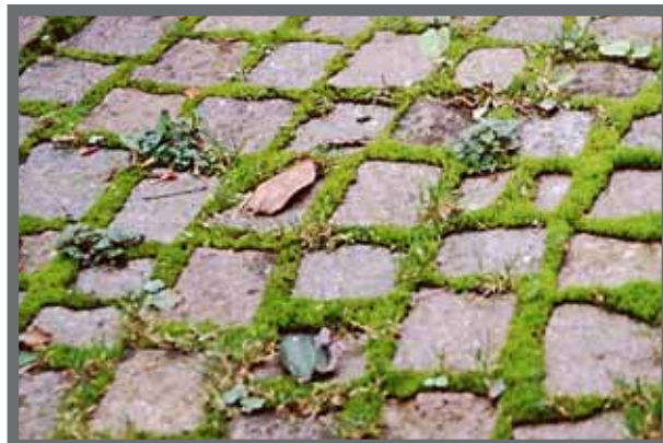
Bild 1 bis 3: Beispiele Begrünbarer Flächenbefestigungen: Fugenbegrünung - Pflaster mit Fugenverbreiterungen (mit/ohne Abstandshalter), Grünanteil bis zu 30 %.
