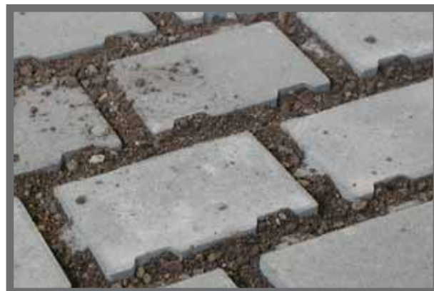
Bild 8: Rezeptur für Bettung und Fugenfüllung: 40 Gew.-% Sand 0-4 mm, 40-50 Gew.-% Splitt 2-5 mm, 10-20 Gew.-% sandig-lehmiger Oberboden.
