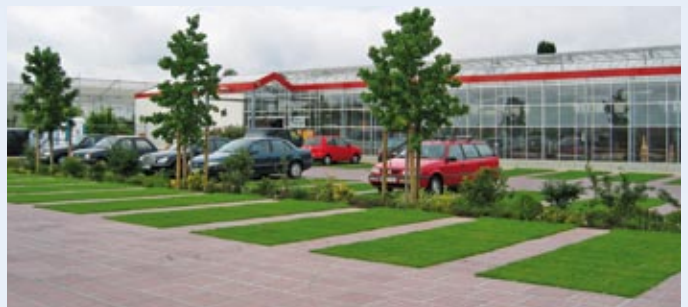
TTE®-MultiDrain Kombilösung für den Parkplatzbau: TTE® Begrünung plus TTE®-Pflastersteine, vor Ort begrünt.
