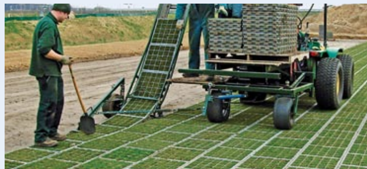
TTE ® direct green wird bei großen Flächen maschinell verlegt
